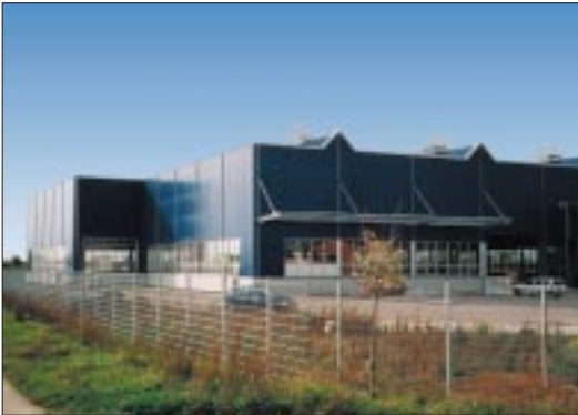
Das neue Produktions- und Bürogebäude der WITEC AG
